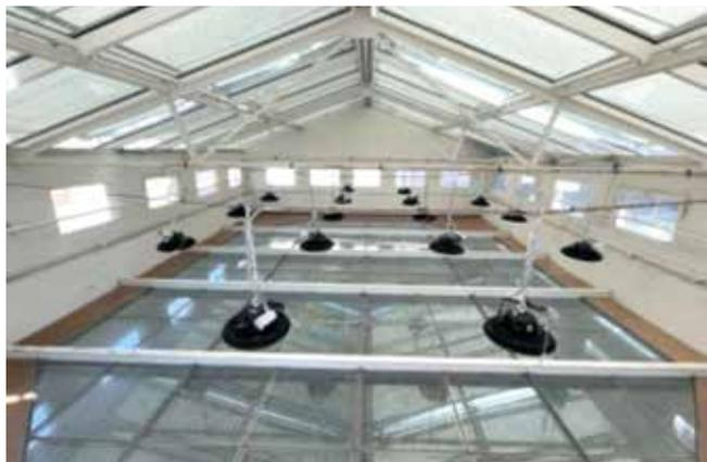
Remplacement de l'éclairage de la coupole de la salle du Grand Conseil par des sources lumineuses LED.
