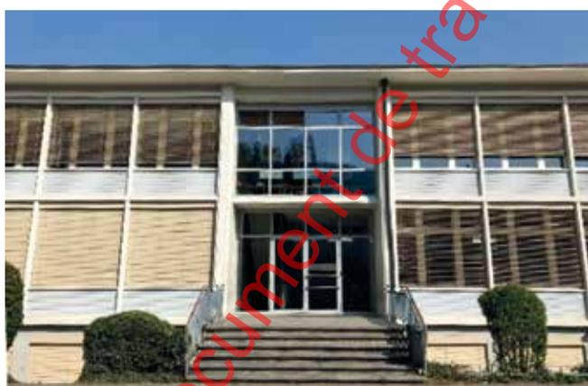
Remplacement des vitrages et portes d'entrée de la façade Sud et des portes Ouest et Est. Compartimentage des couloirs selon mise en conformité feu du bâtiment.
