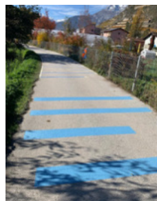
Essai marquage au sol
