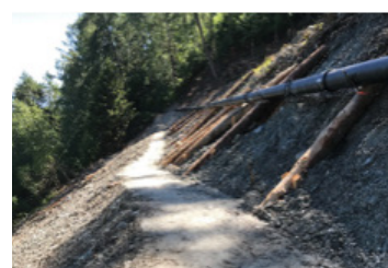
Réfection du bisse de Salins et de son chemin
