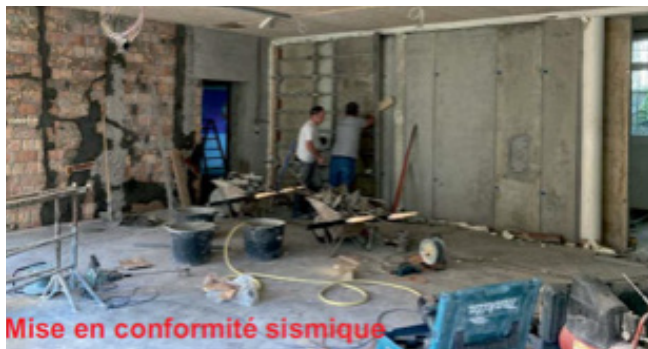
Réfection complète de la structure d'accueil comprenant la mise en conformité feu et la première étape de conformité sismique du bâtiment I.
