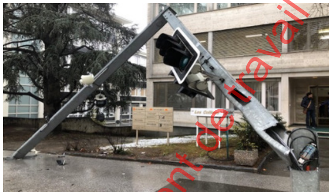
État du portique juste après l'accident
