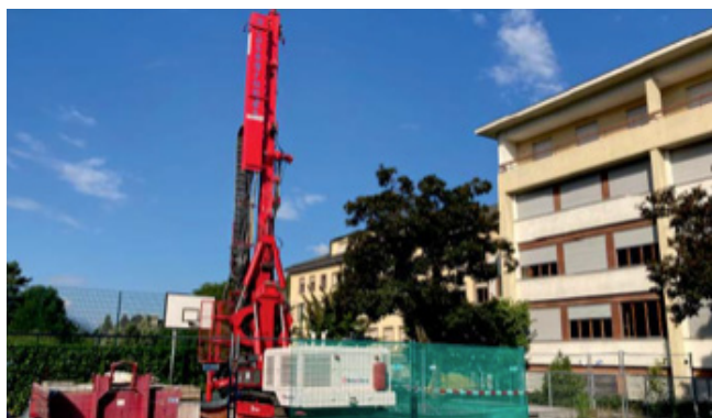
Première étape d'installation d'une production de chaleur centralisée du centre scolaire par la réfection de la chaudière à gaz de 450 kWh et l'exécution d'un forage d'exploration à 200 m en vue de l'installation d'une PAC de 125 kWh
