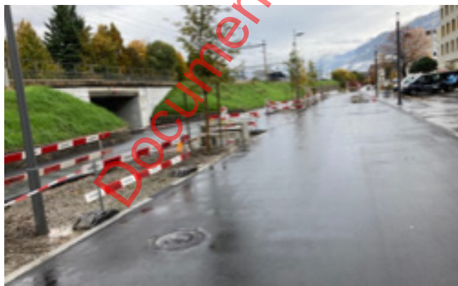
Ambiance rue de la Blancherie durant les travaux
