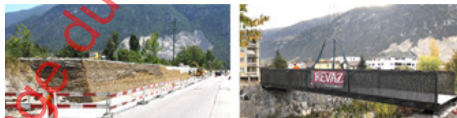
Passerelle sur la Lienne reliant Uvrier à St-Léonard
