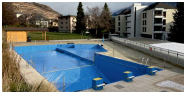
Les travaux comprennent le décapage complet des couches de peinture existante et l'assainissement des bassins ainsi que la réfection complète des façades du bâtiment principal.
