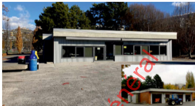
Les travaux comprennent la construction d'une buvette pour le mouvement junior du FC Sion.
