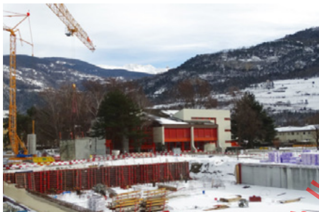
Extension du centre scolaire de Champsec
