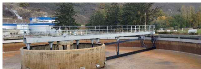
Réhabilitation du décanteur primaire
