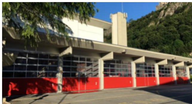
Remplacement des portes de garage par des portes sectionnelles à ouverture rapide selon intervention.
