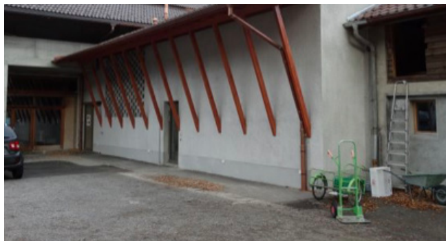
Reconstruction du bâtiment de la cuisine et réaménagement de la zone cuisine du restaurant de la Ferme-Asile.
