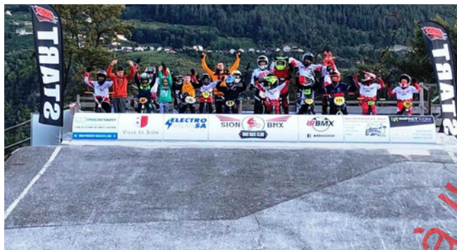
Réfection complète de la grille de départ (y c. du socle) de la piste de BMX.
