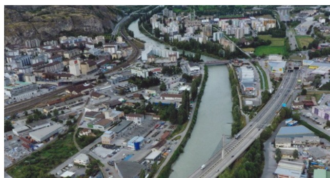
Vue partielle de Sion
