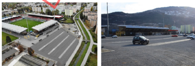
Réfection du parking Nord de Tourbillon
