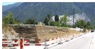
Passerelle sur la Lienne reliant Uvrier à St-Léonard
