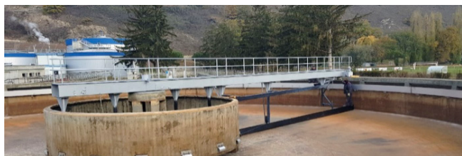
Réhabilitation du décanteur primaire
