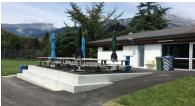
Réfection de la terrasse de la buvette du centre sportif des Glareys.
