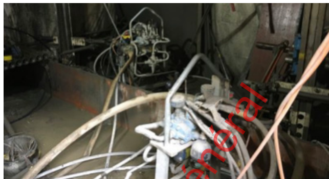
Mise en conformité sismique du premier étage et partielle du rez-de-chaussée du bâtiment.
