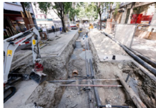
Travaux d'assainissement de l'avenue du Midi ouest
