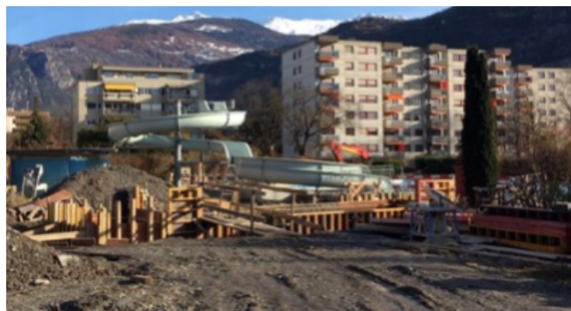
Réfection des infrastructures techniques, ludiques et aquatiques de l'étape pataugeoire et toboggans
