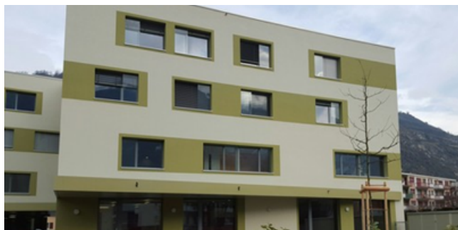
Bâtiment du service des affaires sociales
