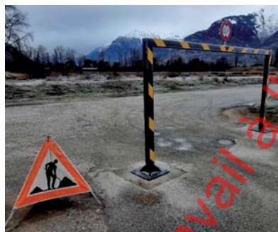
Portique entrée parking lac des Ecussons
