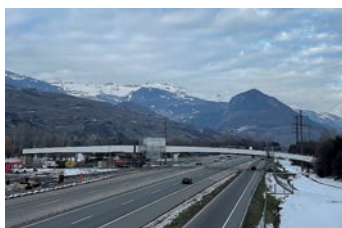
Passerelle de mobilité douce sur l'A9
