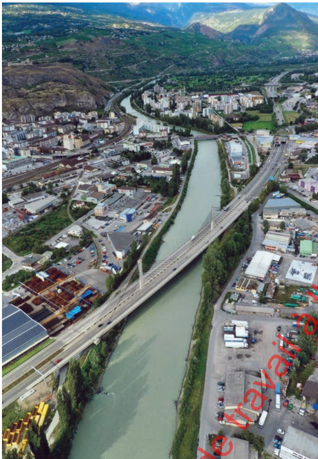
Vue partielle de Sion
