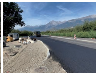
Rte de Bramois, arrêt de bus LHand
