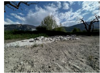
Réalisation de murgier
