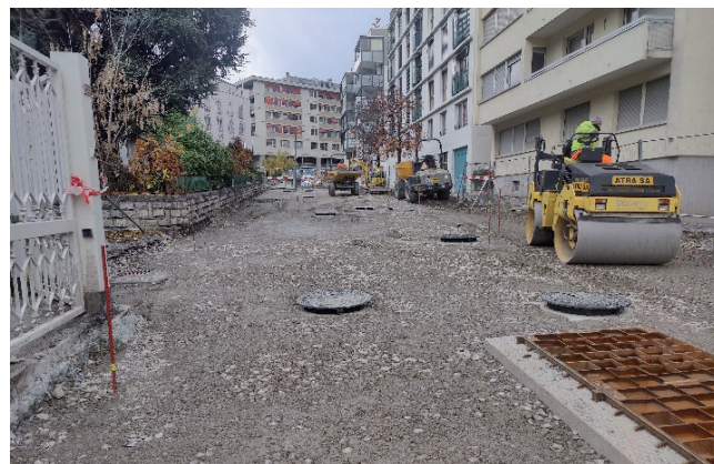
Chantier de la rue des Aubépines à Sion
