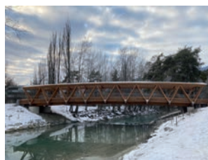
Passerelle de la Borgne
