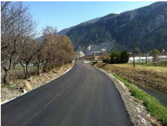
Chantiers de la rue Chanoine Berchtold et de la route de la Plaine à Uvrier
