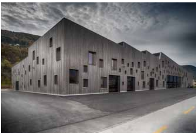
La nouvelle voirie inaugurée le 1er décembre 2012
