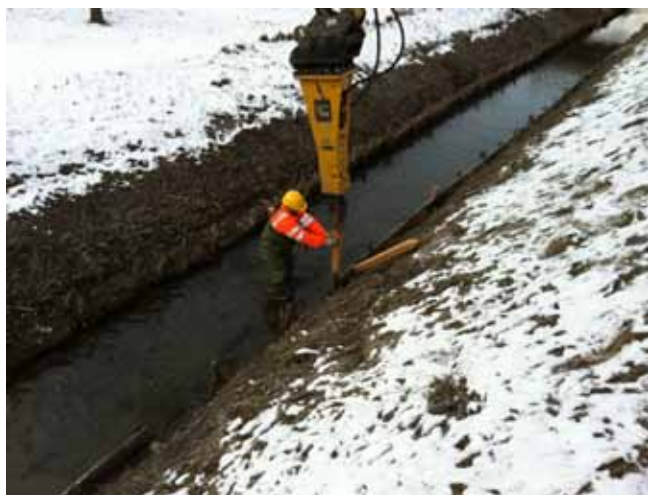
Entretien du canal d'Uvrier
