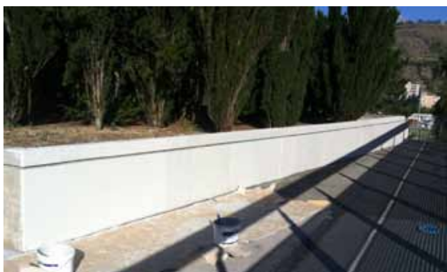
L'un des murs nettoyé en 2012
