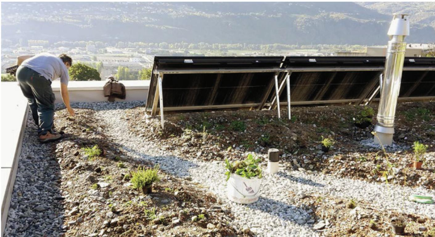
Cette toiture végétalisée, réalisée en partenariat avec des propriétaires privés subventionnés, a été créée en récupérant la terre d'excavation, aérée grâce à de la brique concassée. Toute toiture végétalisée joue un rôle d'éponge qui retient l'eau, rafraîchit et préserve le bâtiment. C'est l'une des recommandations préconisées par le guide ACCLIMATASION.
